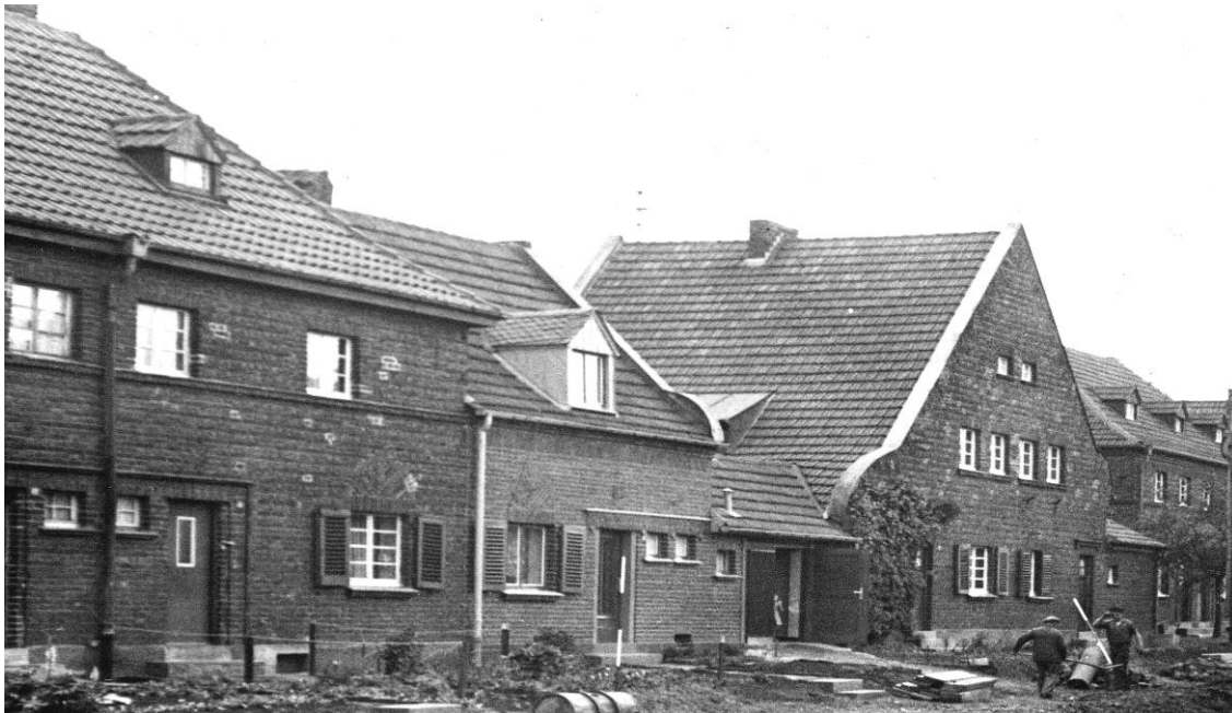
Arbeitersiedlung in Köttingen
