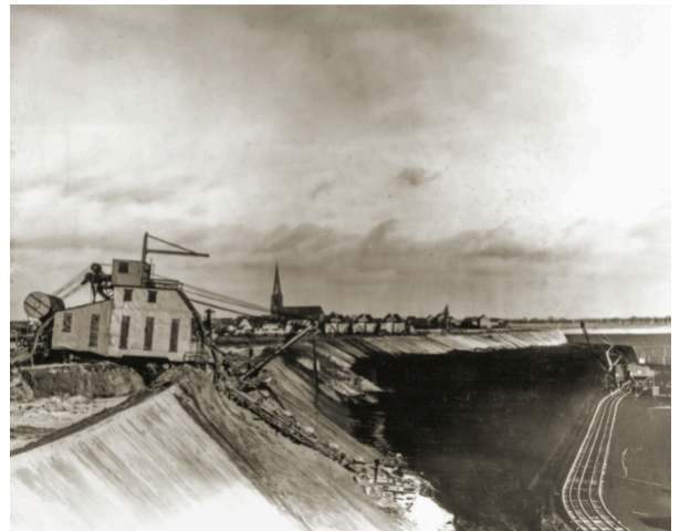
Löffelbagger in der Grube Fürstenberg, im Hintergrund Bottenbroich, um 1925, Foto: Stadtarchiv Kerpen
